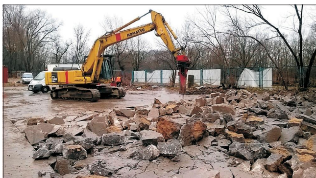
Рис. 1. Попереднє подрібнення бетонного покриття з використанням молотка для знесення
