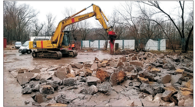
Fig. 1. Pre-crushing of a concrete pavement with the use of a demolition hammer Rys. 1. Wstępne kruszenie nawierzchni betonowej przy użyciu młota wyburzeniowego
